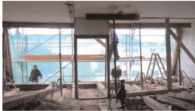
...während der Bauarbeiten Foto: SEGes
